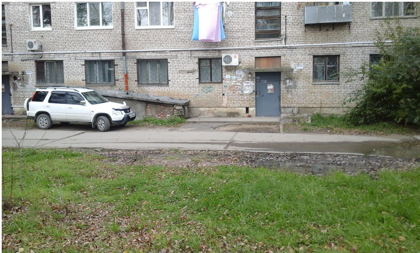
Дворовая территория многоквартирного дома по пр. Комсомольский, д.12 до благоустройства
