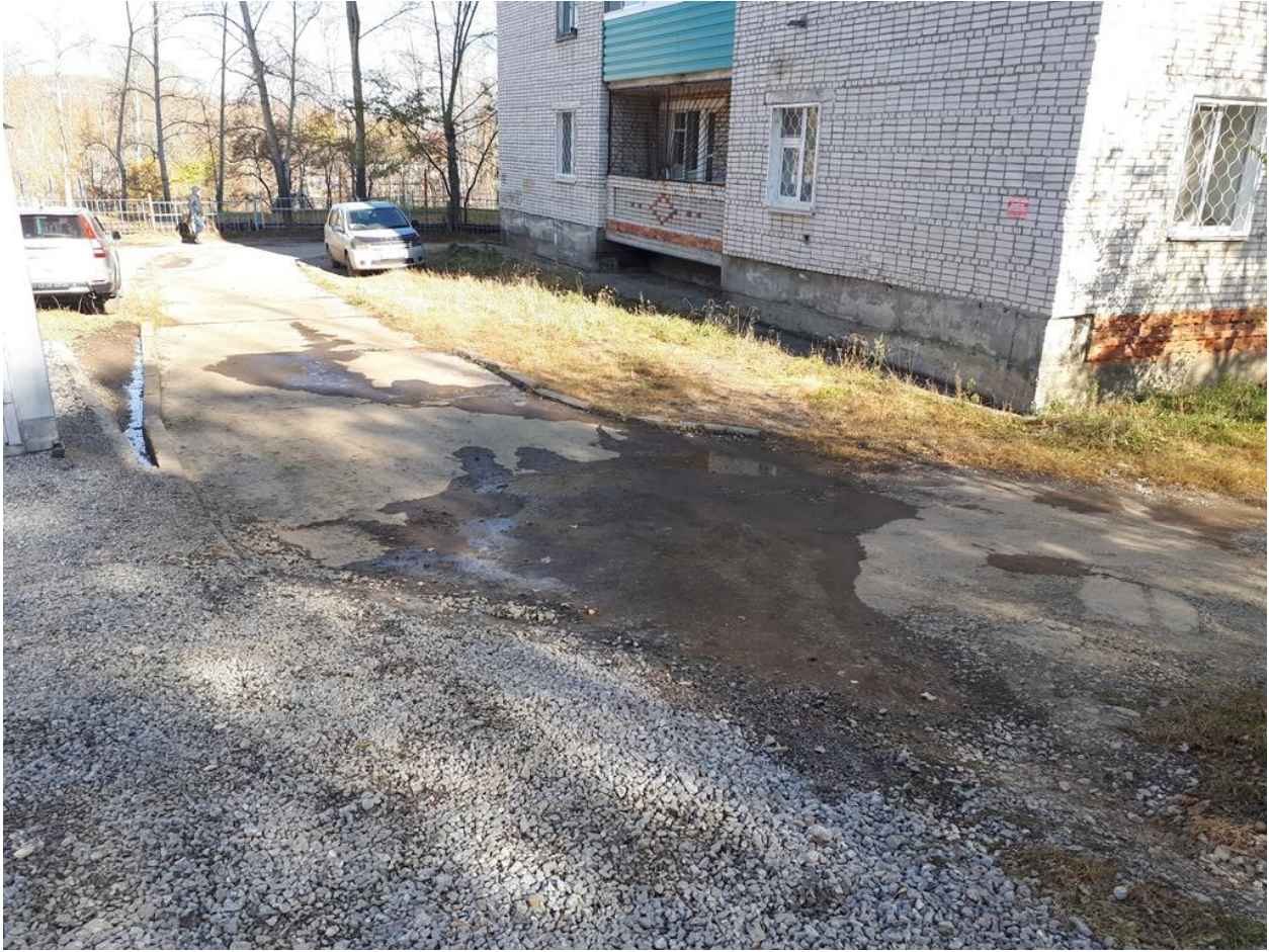
Дворовая территория многоквартирного дома по пр. Комсомольский, д.34 до благоустройства
