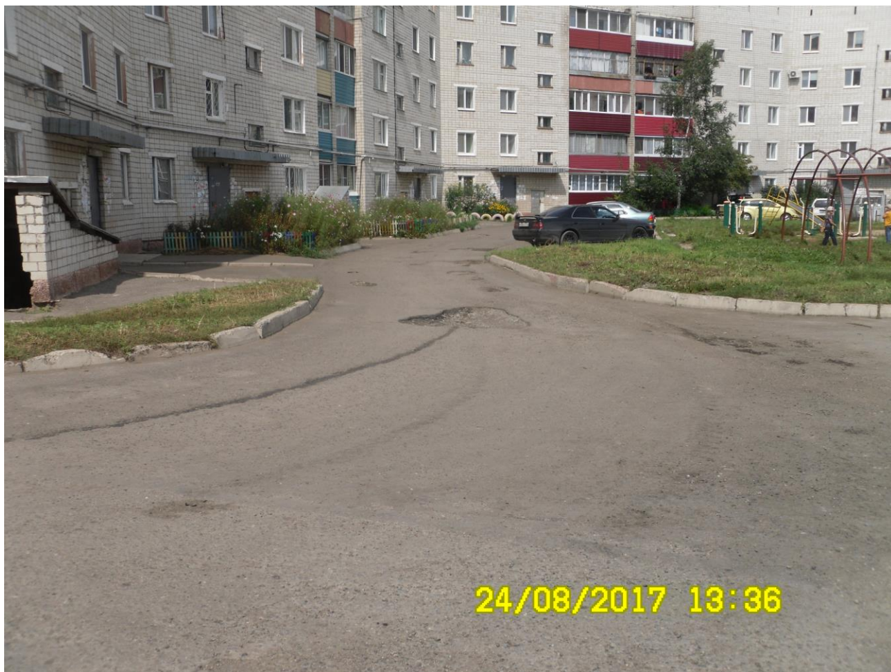
Дворовая территория многоквартирного дома по пр. Комсомольский, д.55 до благоустройства
