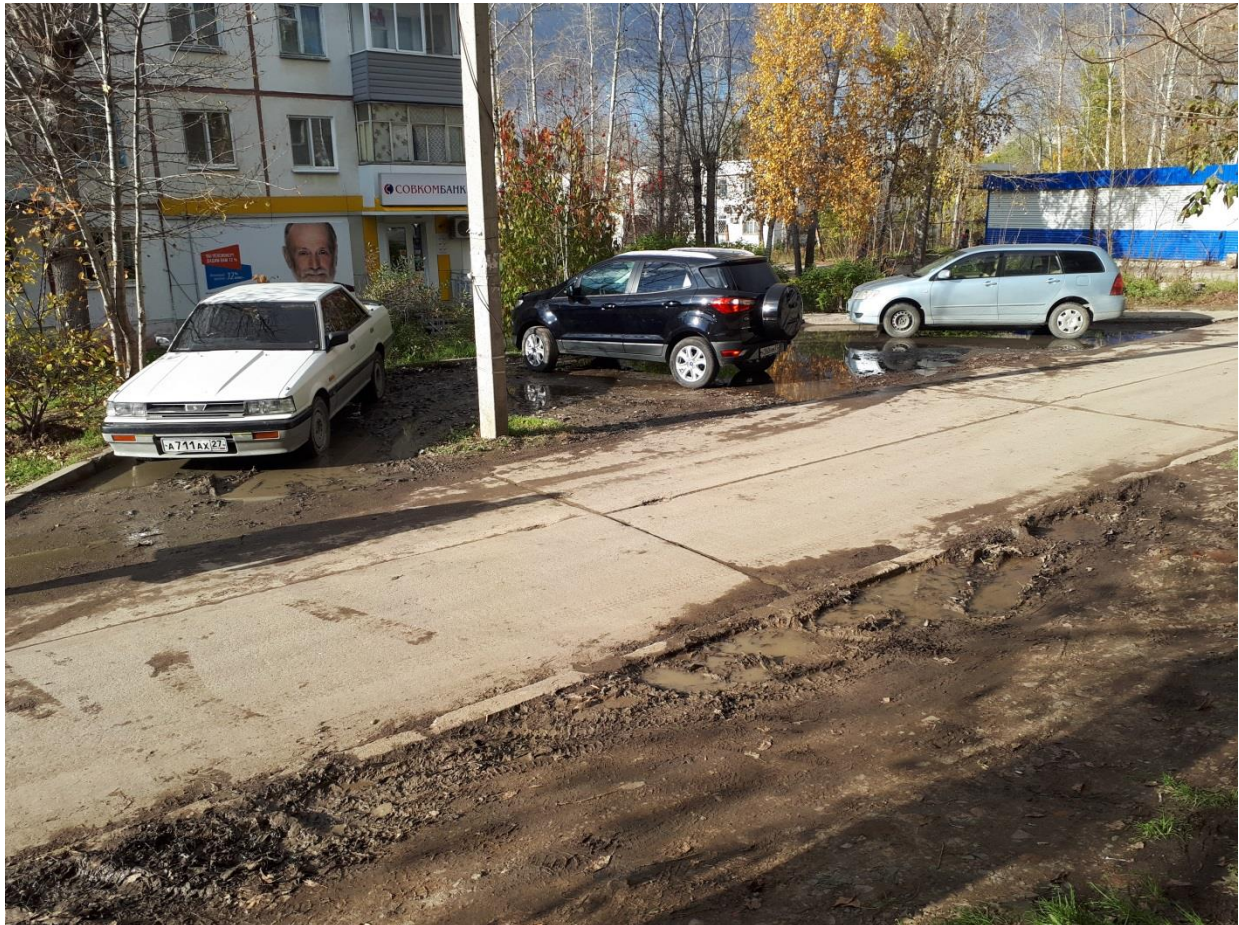
Дворовая территория многоквартирного дома по пр. Комсомольский, д.9 до благоустройства
