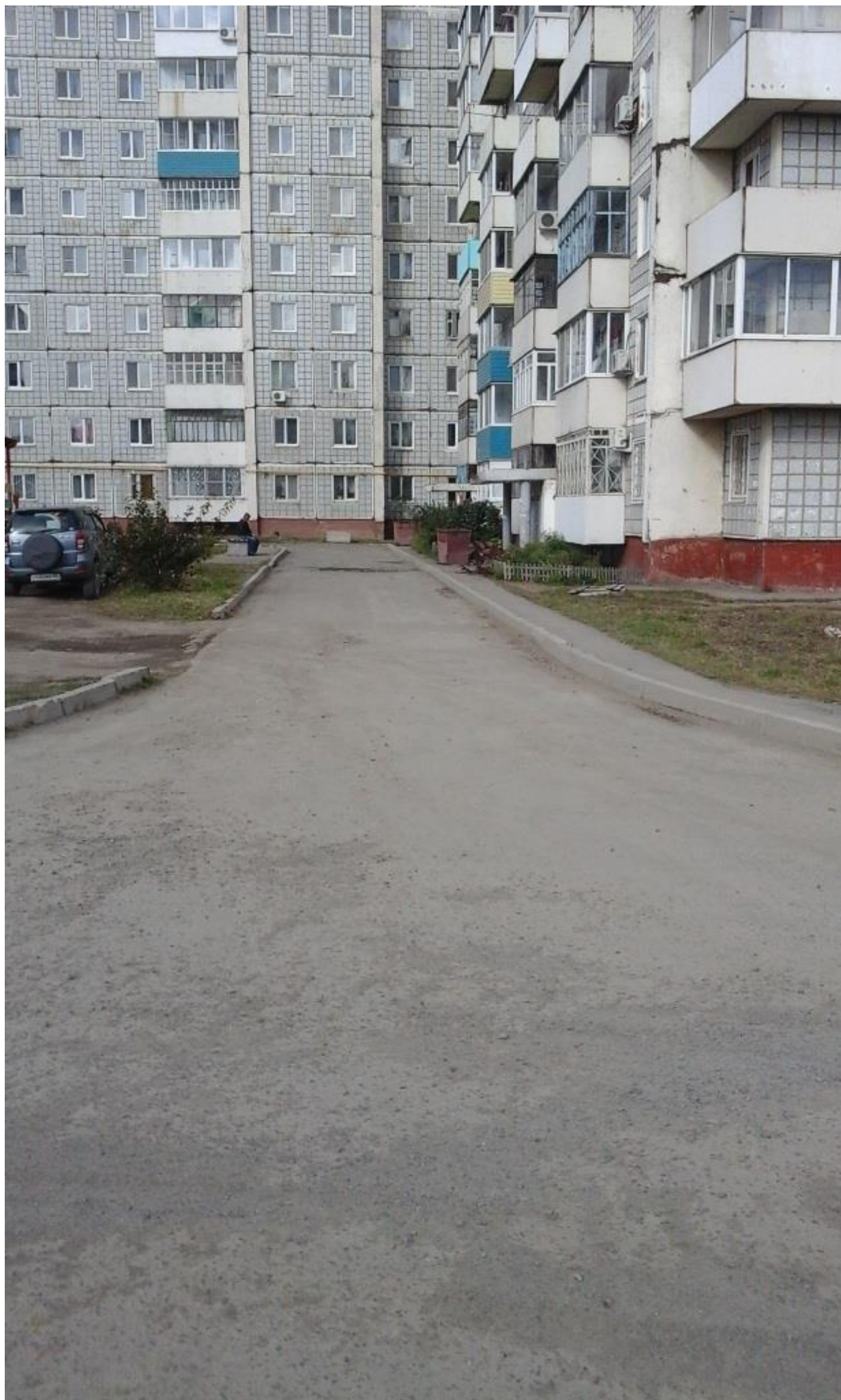
Дворовая территория многоквартирного дома по ул. Пионерская, д.11а до благоустройства
