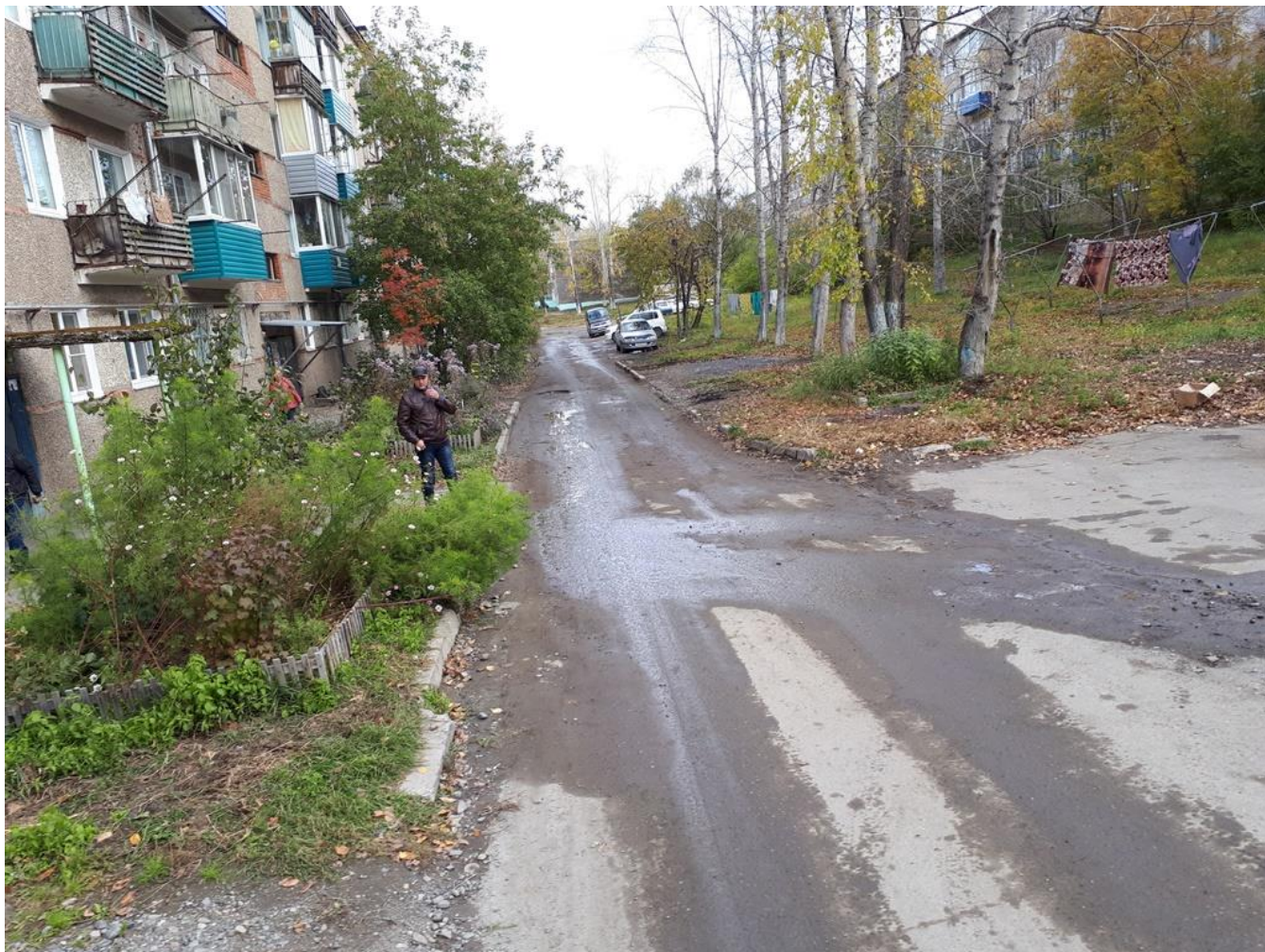
Дворовая территория многоквартирного дома по пр. Победы, д.14 до благоустройства
