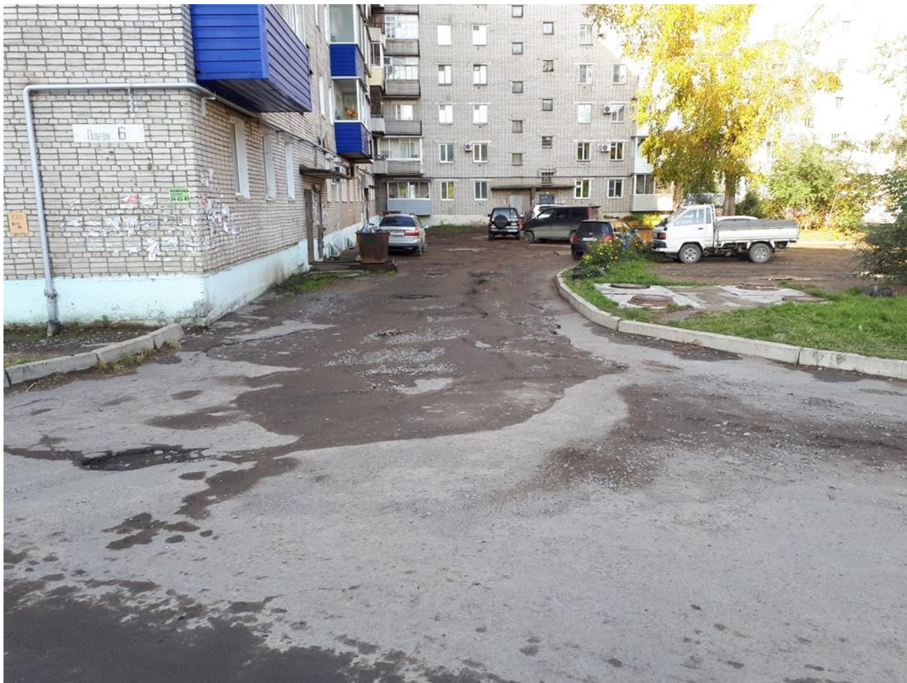
Дворовая территория многоквартирного дома по пр. Победы, д.6 до благоустройства
