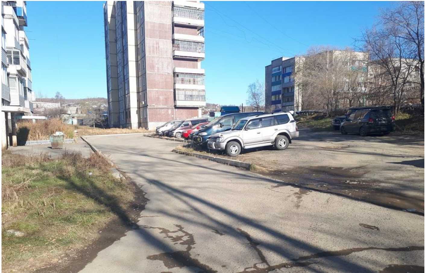
Дворовая территория многоквартирного дома по пр. Строителей, д.20 до благоустройства
