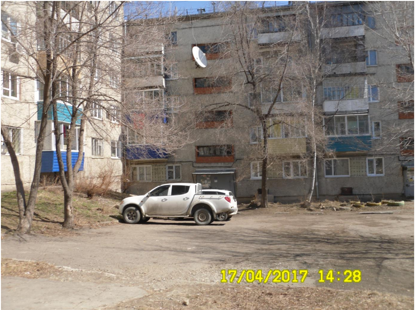
Дворовая территория многоквартирного дома по пр. Строителей, д.33 до благоустройства
