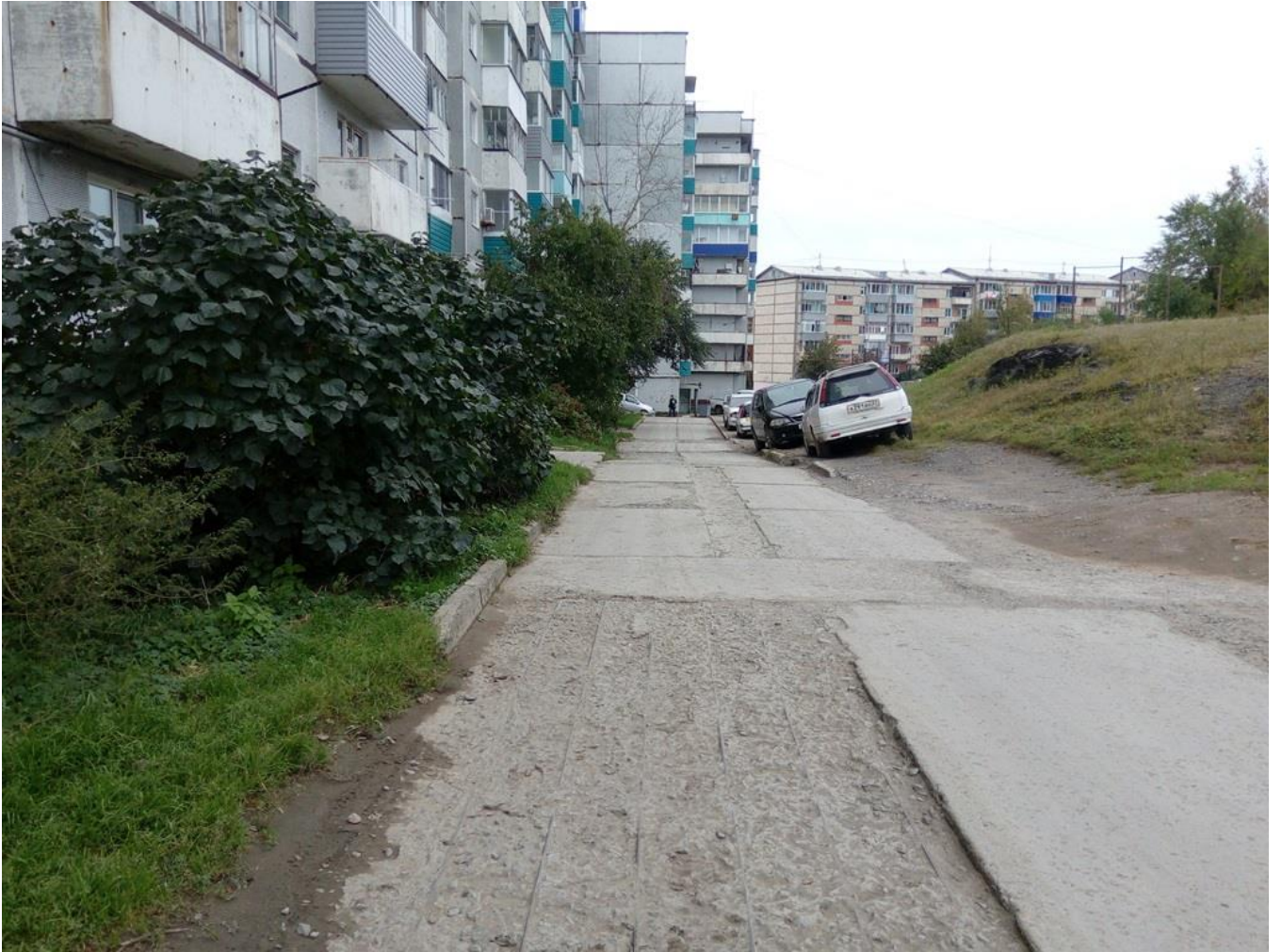
Дворовая территория многоквартирного дома по пр. Строителей, д.42 до благоустройства
