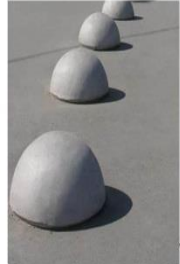
Рисунок 2. Полушеры - ограничители проезда легковых машин (шаг - не более 2 м).
